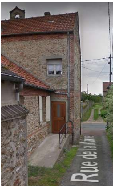
Rampe d'accès PMR
